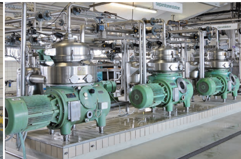
La levure liquide est séparée du moût fermenté dans les centrifugeuses.
